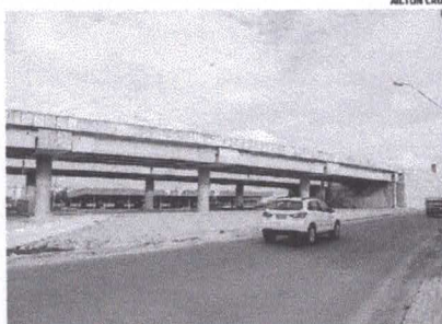
Construído com recursos federais, o viaduto da PRF vai melhorar a mobilidade urbana na região
